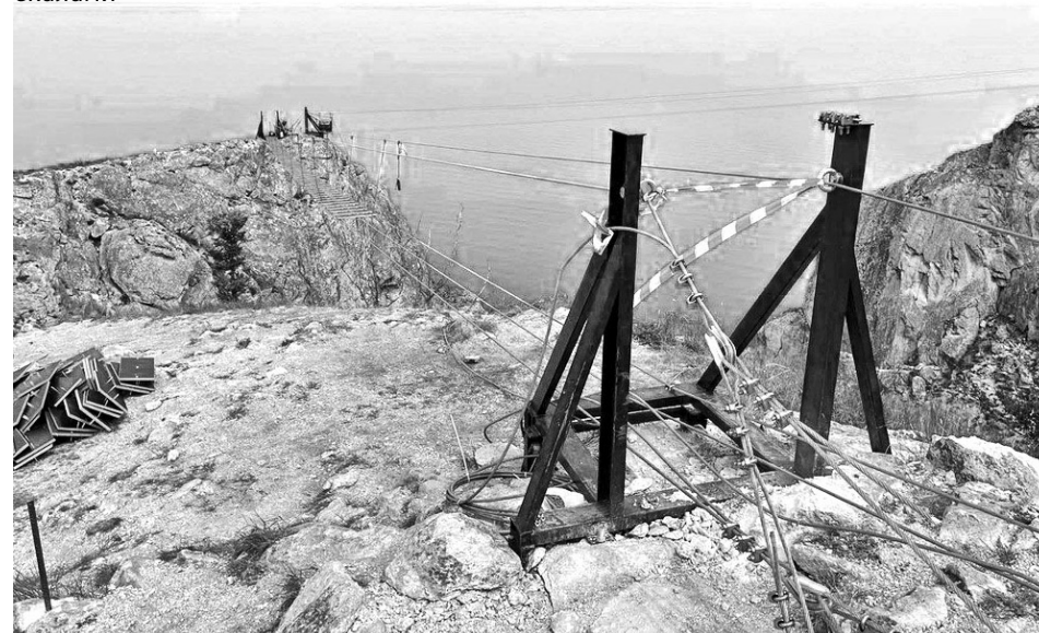
На мысе Саган-Хушун острова Ольхон устанавливаются подвесные переходы между скалами
