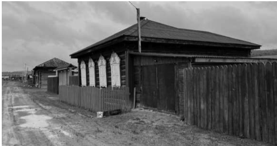
Фотография № 1. Вид с улицы Центральная на юго-восточный и северо-восточный фасады объекта культурного наследия
