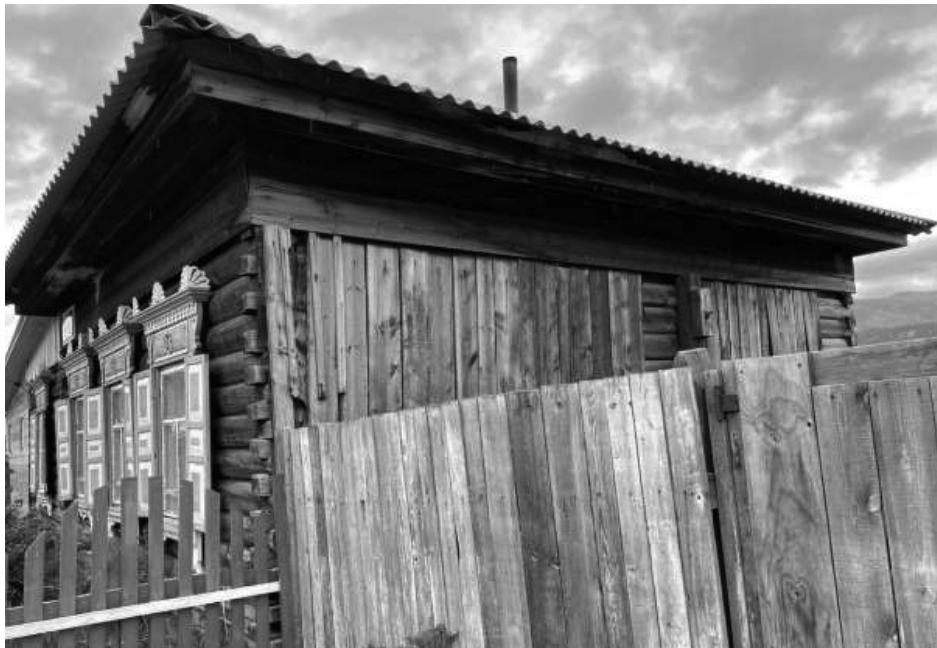
Фотография № 3. Вид на юго-западный и северо-западный фасады объекта культурного наследия
