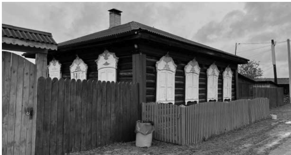
Фотография № 2. Вид на юго-восточный и юго-западный фасады объекта культурного наследия
