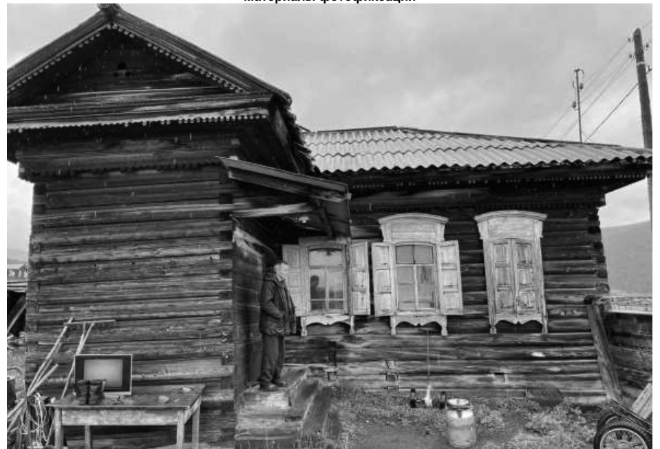
Фотография №1. Вид на юго-западный фасад объекта культурного наследия
