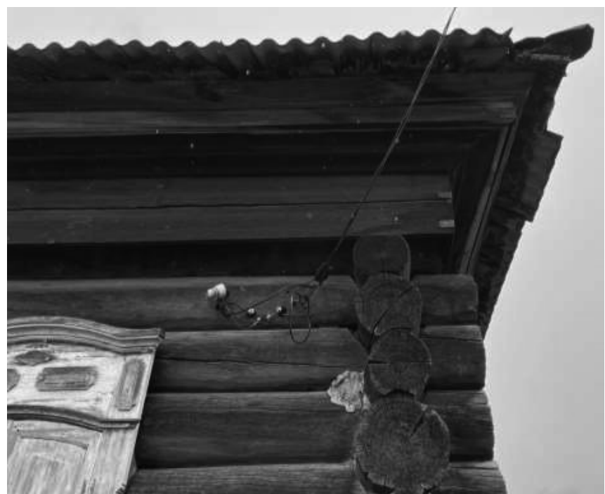
Фотография № 4. Фрагмент юго-западного фасада объекта культурного наследия
