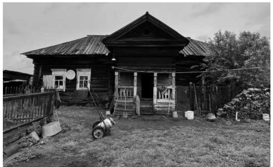
Фотография № 3. Вид на юго-западный фасад объекта культурного наследия
