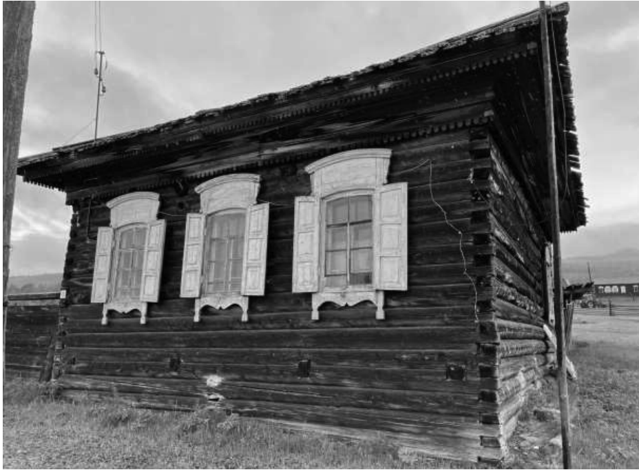
Фотография №3. Вид на юго-восточный и северо-восточный фасады объекта культурного наследия
