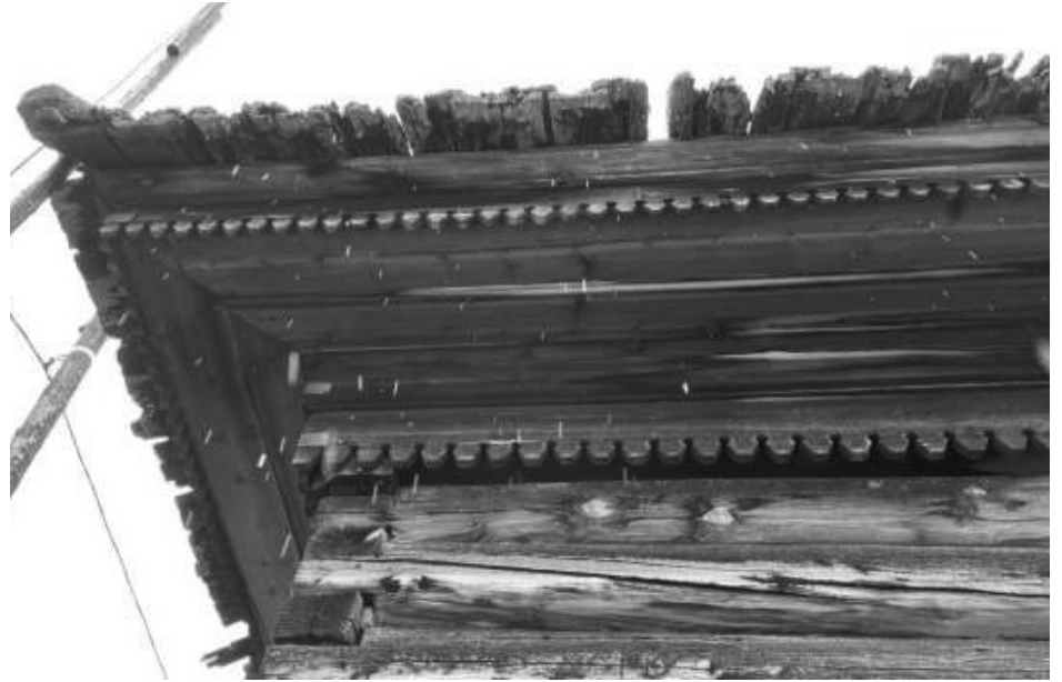
Фотография №4. Фрагмент северо-восточного фасада объекта культурного наследия
