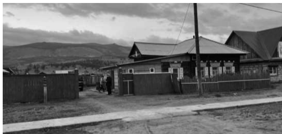
Фотография № 2. Вид с ул. 50 лет Победы на северо-западный и северо-восточный фасады объекта культурного наследия
