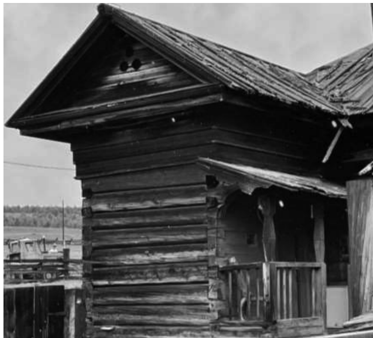
Фотография № 4. Фрагмент юго-западного фасада объекта культурного наследия
