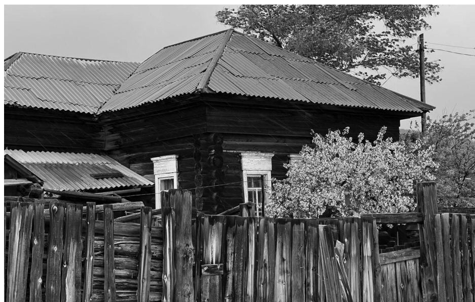
Фотография № 3. Вид на юго-восточный и юго-западный фасады объекта культурного наследия
