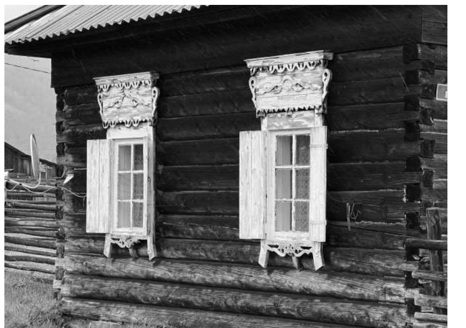
Фотография № 4. Фрагмент восточного фасада объекта культурного наследия
