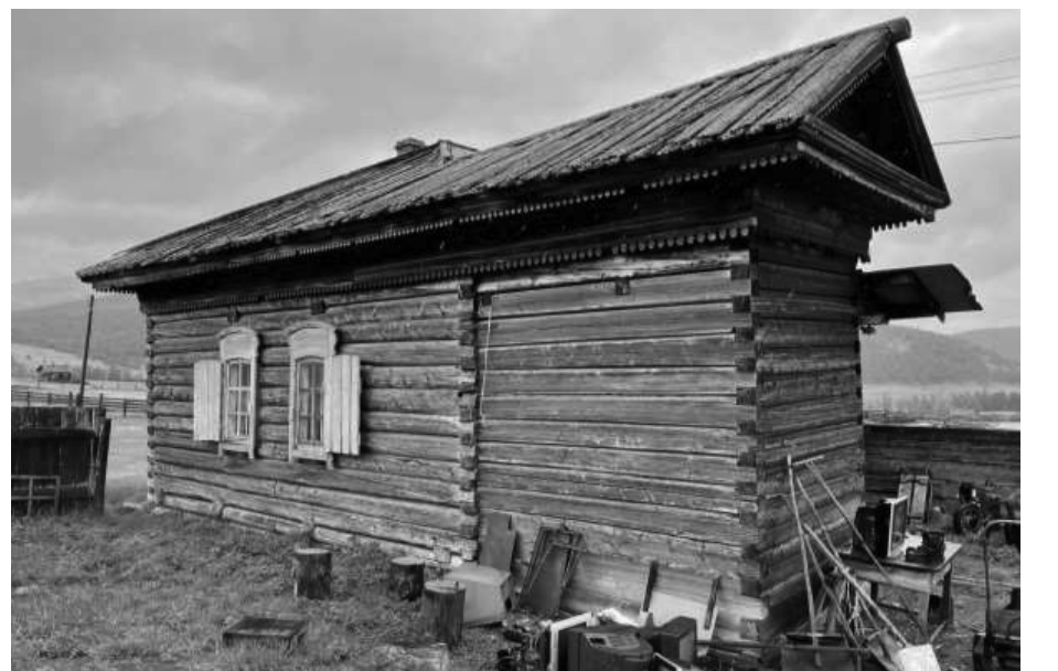
Фотография №2. Вид на юго-западный и северо-западный фасады объекта культурного наследия
