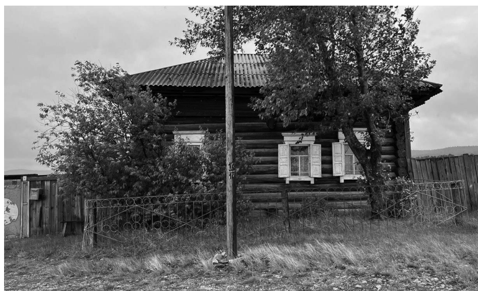
Фотография № 2. Вид с ул. Заеланская на северо-восточный фасад объекта культурного наследия
