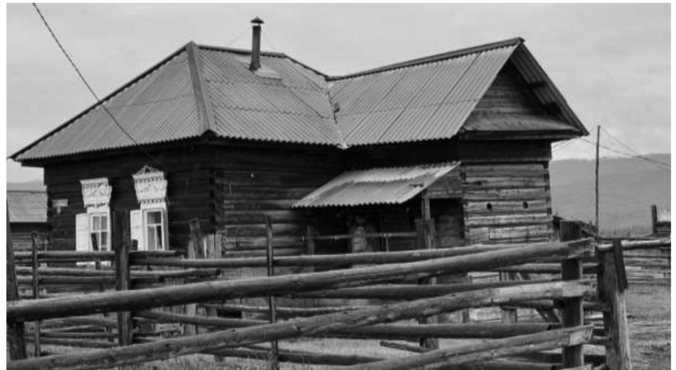
Фотография № 1. Вид на северный и восточный фасады объекта культурного наследия
