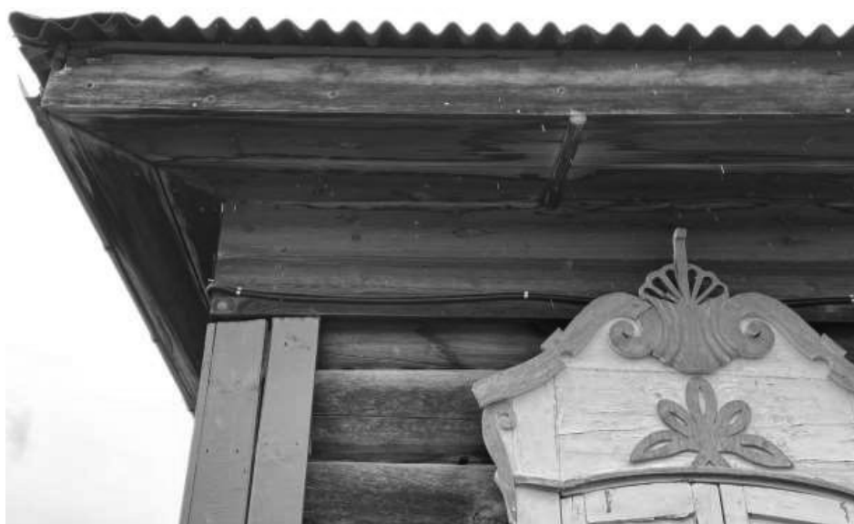
Фотография № 4. Фрагмент юго-восточного фасада объекта культурного наследия
