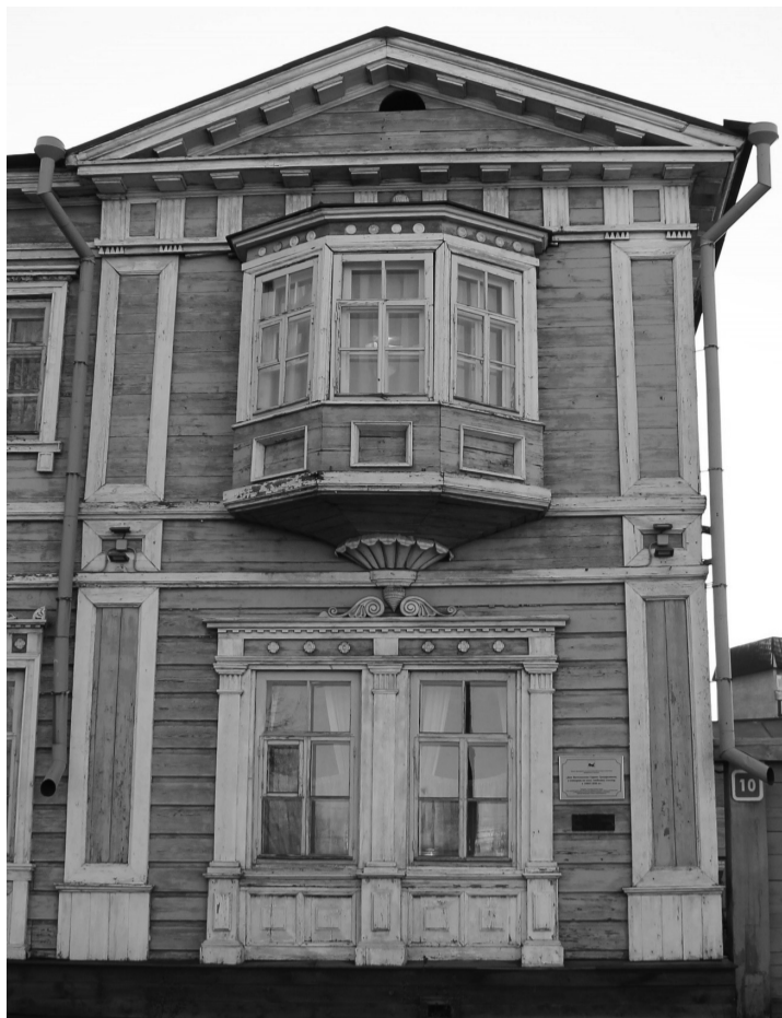
Фото 5. Фрагмент северо-западного фасада.
