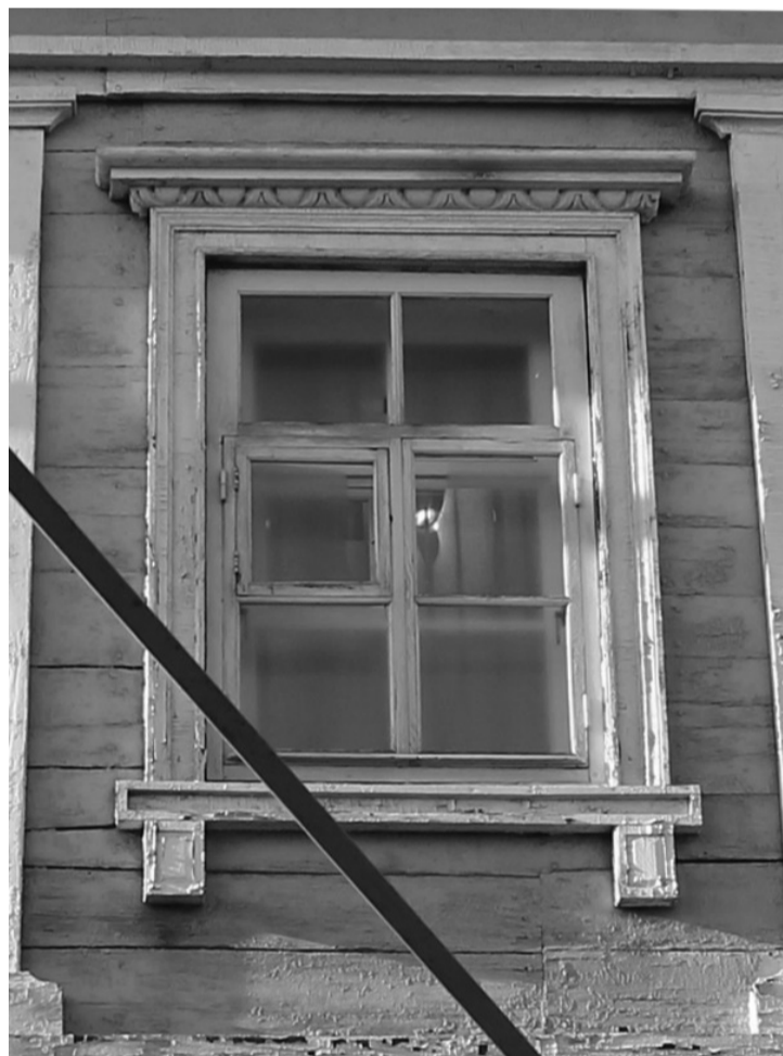
Фото 34. Наличник оконного проема второго этажа, северо-восточный фасад.
