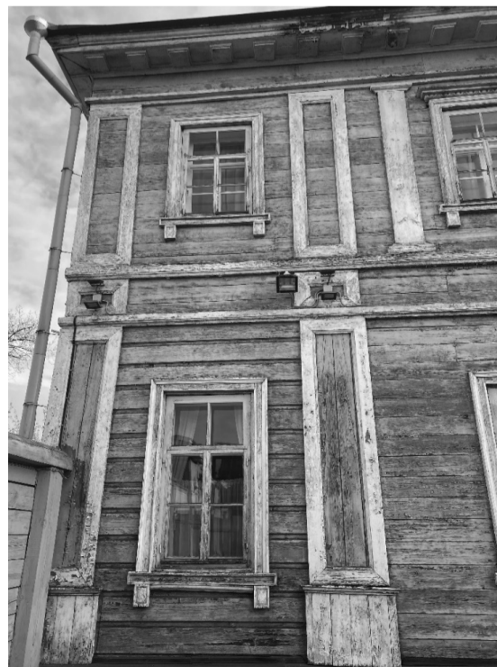
Фото 11. Фрагмент юго-западного фасада.
