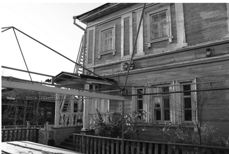
Фото 29. Фрагмент северо-восточного фасада.
