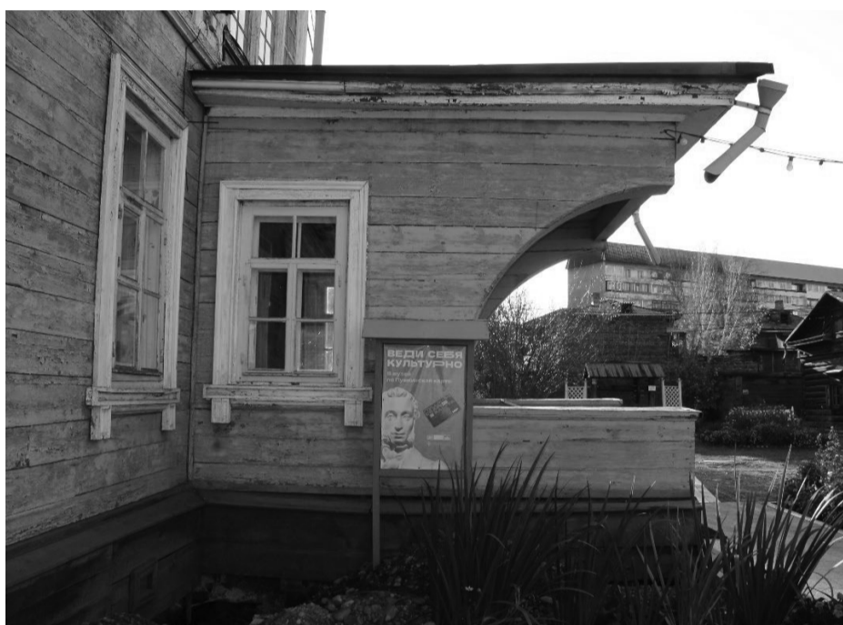
Фото 13. Крыльцо парадного входа с северо-западной стороны.
