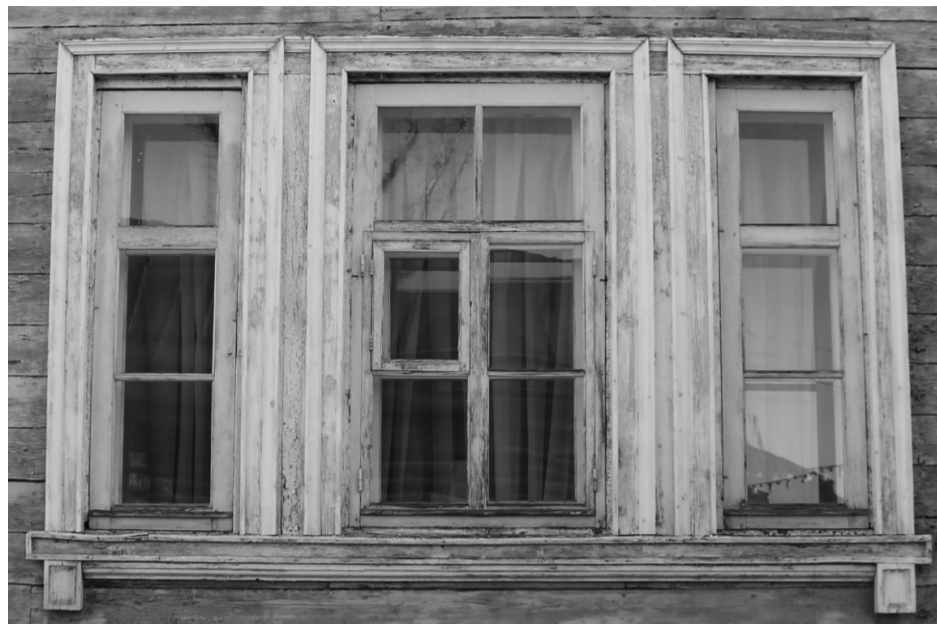
Фото 16. Наличник трехчастного оконного проема первого этажа, юго-западный фасад.
