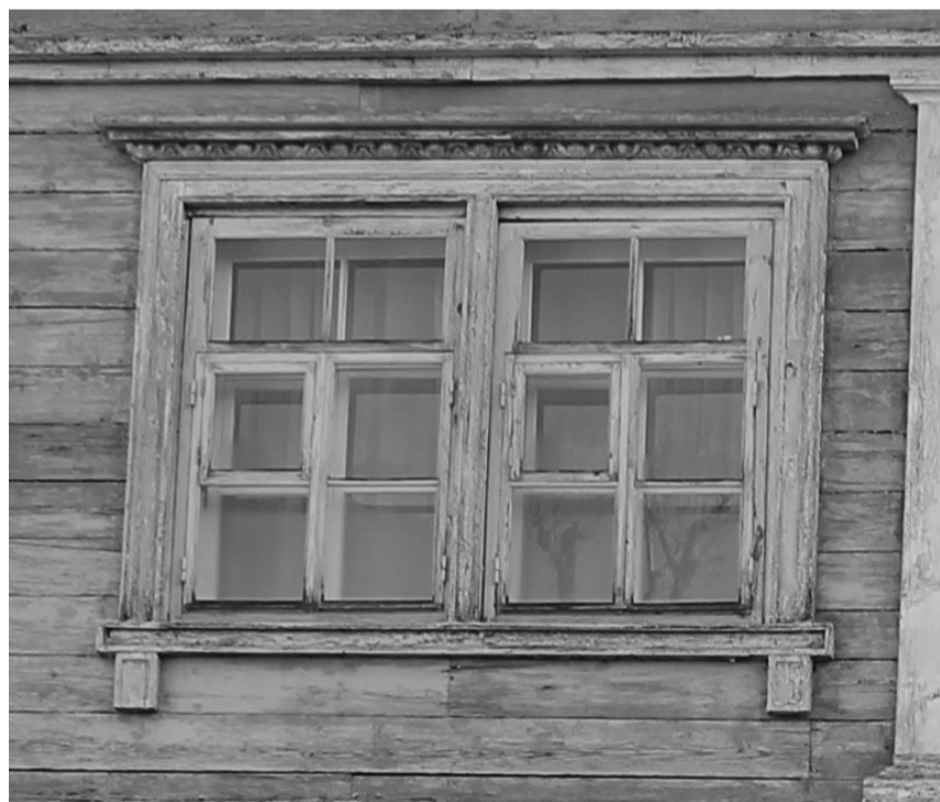
Фото 18. Наличник спаренного оконного проема второго этажа, юго-западный фасад.
