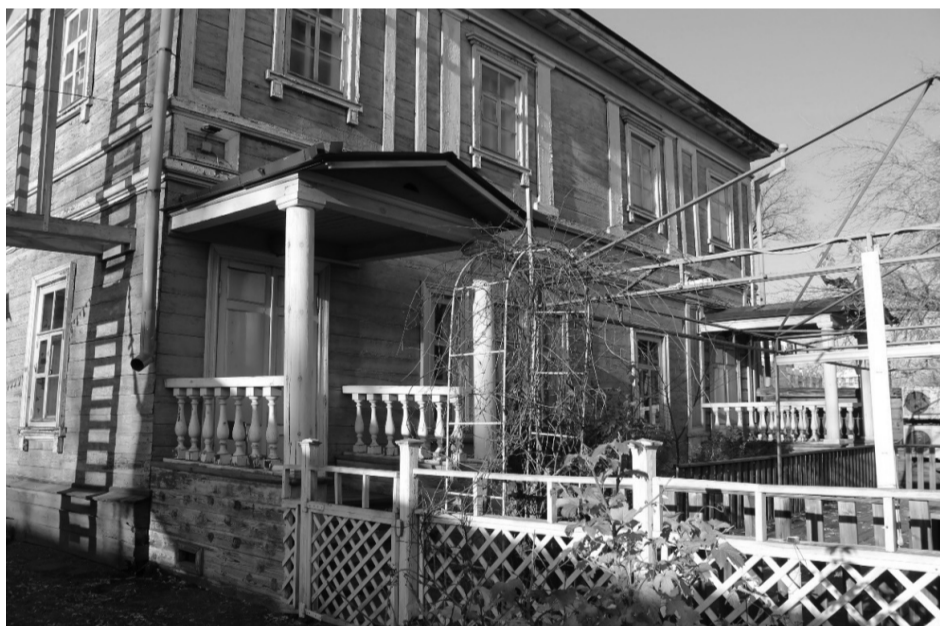
Фото 28. Фрагмент северо-восточного фасада.
