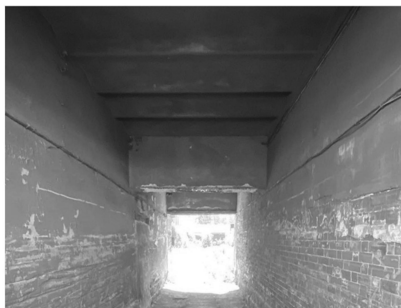
Фотография № 4. Вид фрагмент фасада объекта культурного наследия
