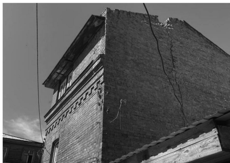
Фотография № 3. Вид фрагмент фасада объекта культурного наследия
