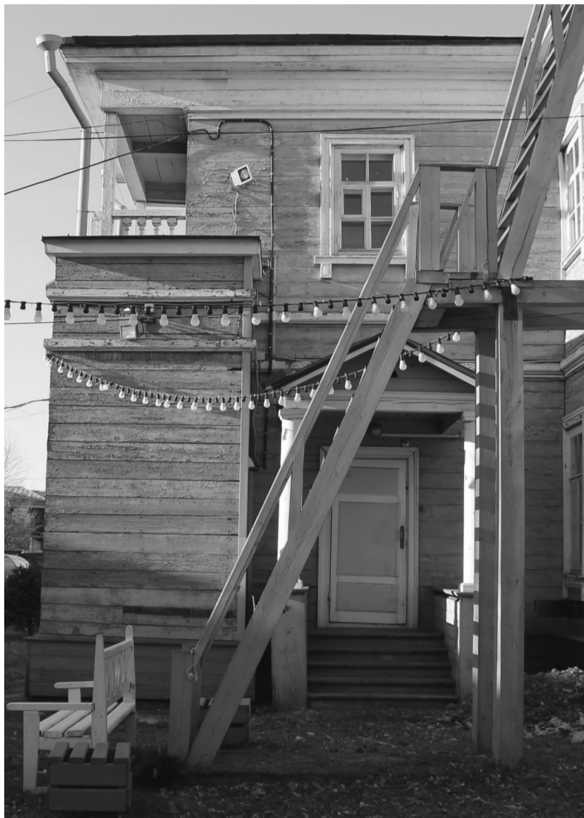
Фото 27. Фрагмент северо-восточного фасада, крыльцо черного входа.
