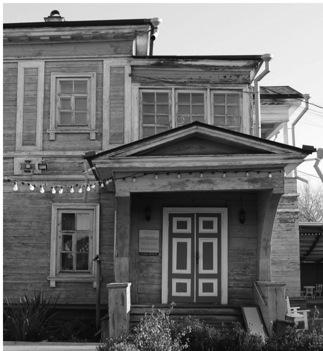
Фото 12. Фрагмент юго-западного фасада, дворовый прибор с верандой-светелкой и парадное крыльцо.
