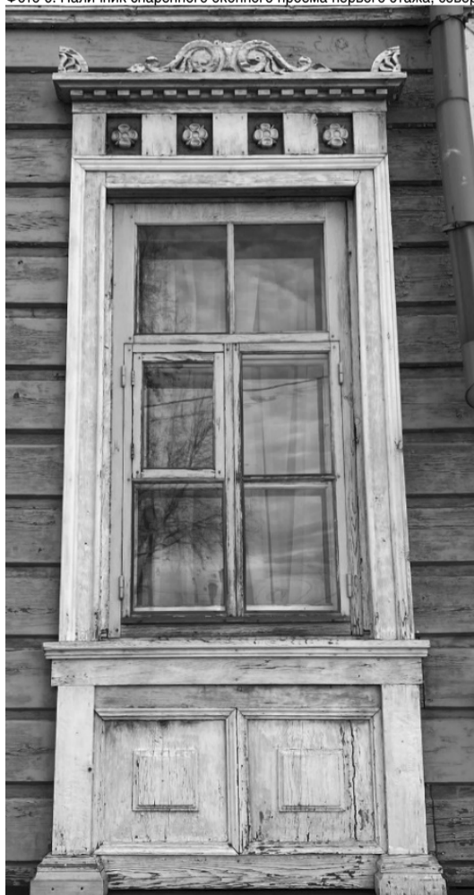
Фото 7. Наличник оконного проема первого этажа, северо-западный фасад.
