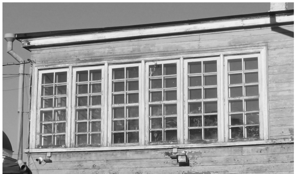
Фото 25. Ленточное остекление веранды-светелки, юго-восточный фасад.
