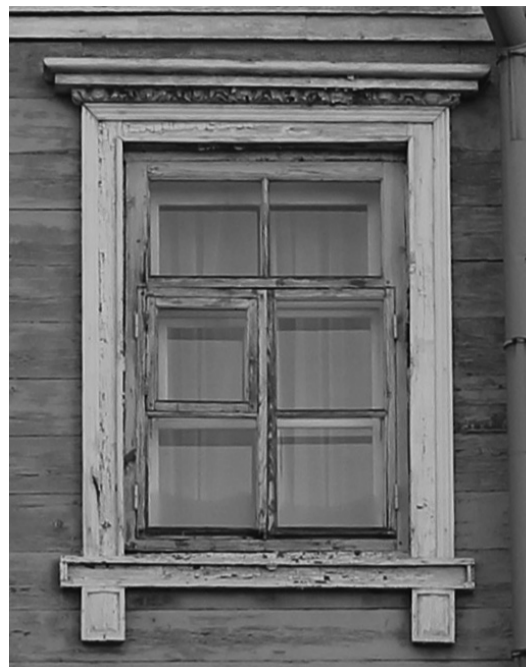
Фото 8. Наличник оконного проема второго этажа, северо-западный фасад.
