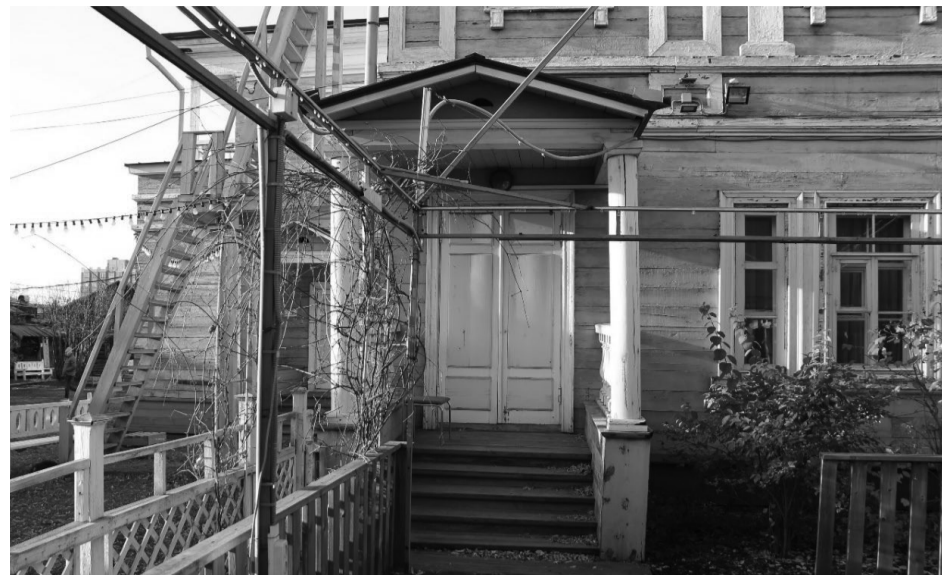
Фото 30. Крыльцо северо-восточного фасада.
