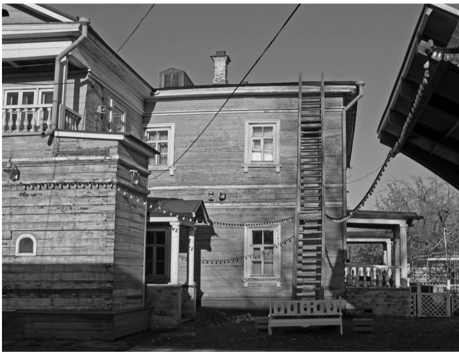
Фото 21. Фрагмент юго-восточного фасада.
