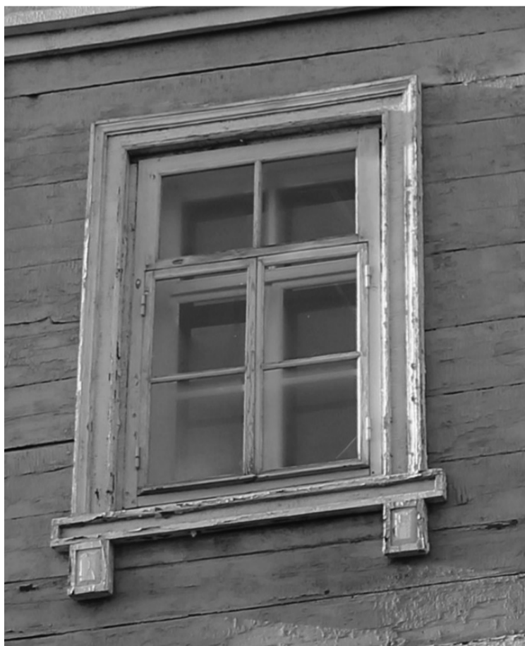
Фото 35. Наличник оконного проема второго этажа, северо-восточный фасад.
