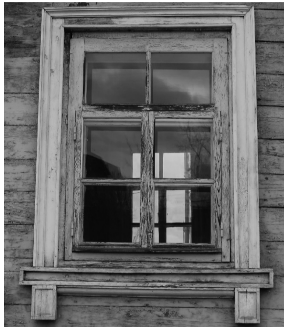
Фото 24. Наличник оконного проема первого этажа, юго-восточный фасад (крыльцо парадного входа).
