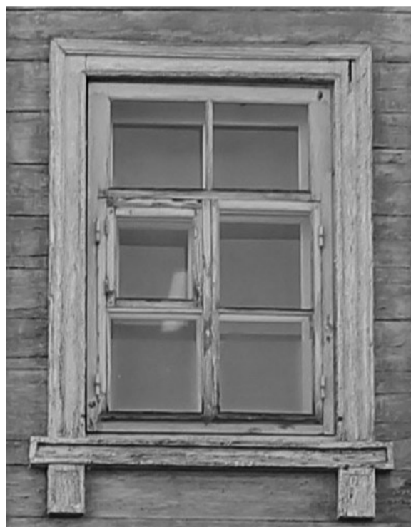
Фото 17. Наличник оконного проема второго этажа, юго-западный фасад.
