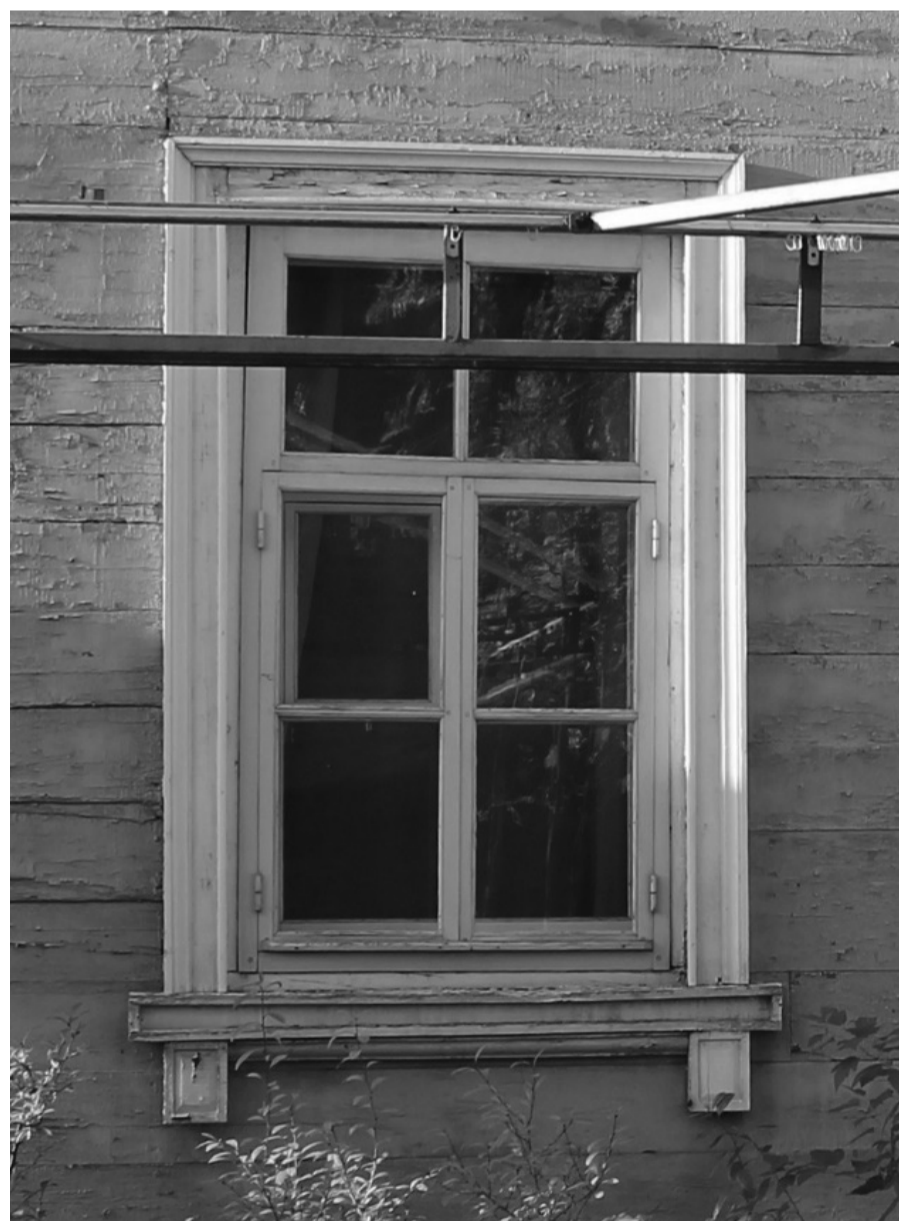
Фото 32. Наличник оконного проема первого этажа, северо-восточный фасад.
