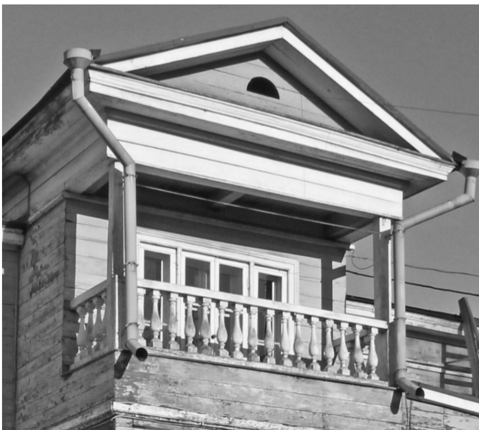
Фото 22. Фрагмент переруба с балконом, юго-восточный фасад.
