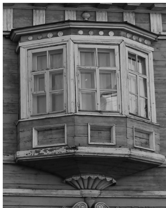
Фото 9. Эркер, северо-западный фасад.
