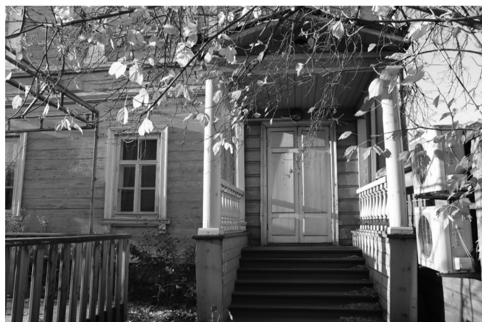
Фото 31. Крыльцо северо-восточного фасада.
