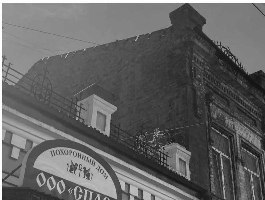
Фотография № 2. Вид фрагмент фасада объекта культурного наследия
