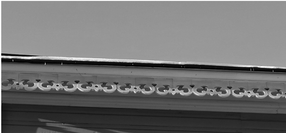
Фото 2 – Юго-западный фасад (главный). Карниз
