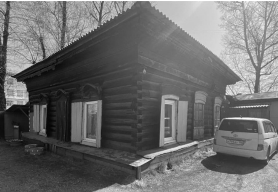
Фото 2 – Вид на здание с восточного угла
