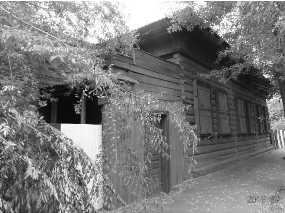
Фото 2 – Вид ОКН с северо-запада (фото 2018 г.)
