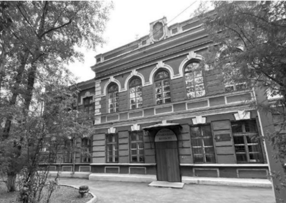
Фото 1 – Фрагмент главного фасада
