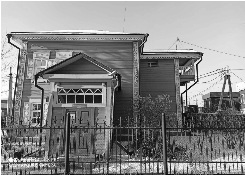
Фото 3 – Юго-восточный фасад (боковой)
