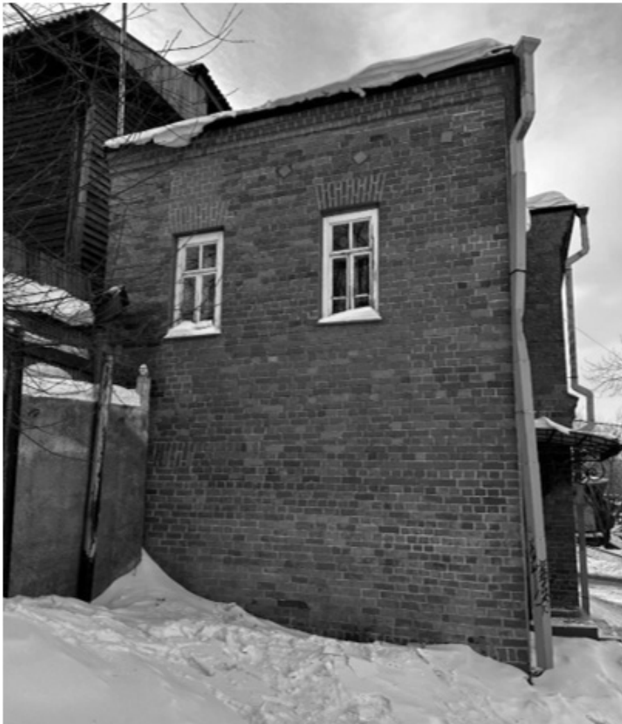
Фото 3 – Дворовой (восточный) фасад входного пристроя
