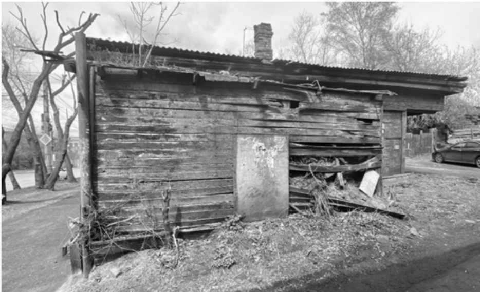
Фото 4 – Боковой (южный) фасад
