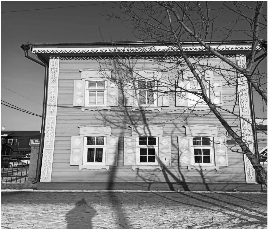
Фото 1 – Главный (юго-западный) фасад
