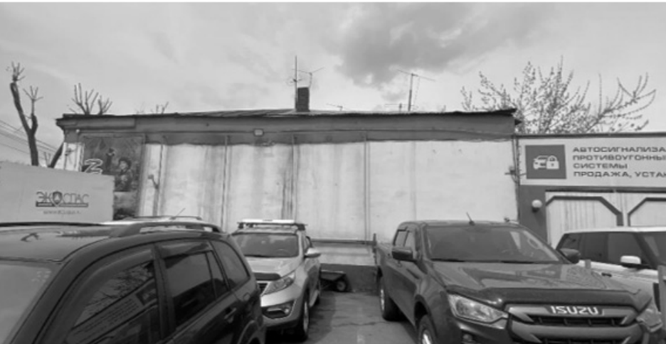
Фото 4 – Боковой (южный) фасад
