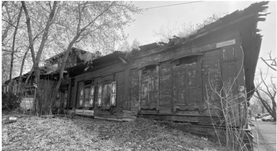
Фото 2 – Фрагмент бокового (северного) фасада
