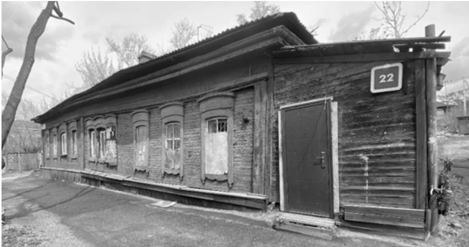
Фото 1 – Главный (западный) фасад дома
