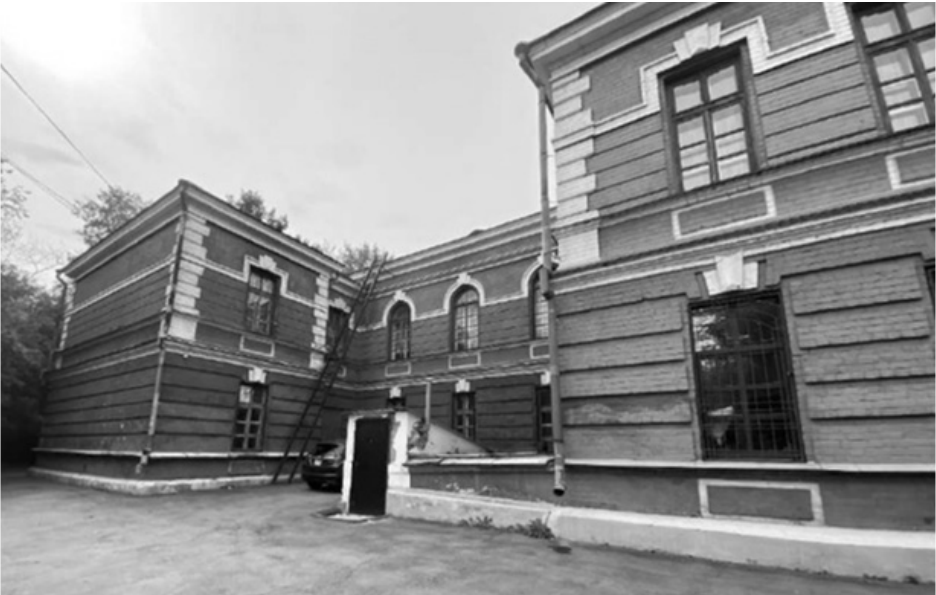
Фото 3 – Вид на дворовой фасад с северо-востока
