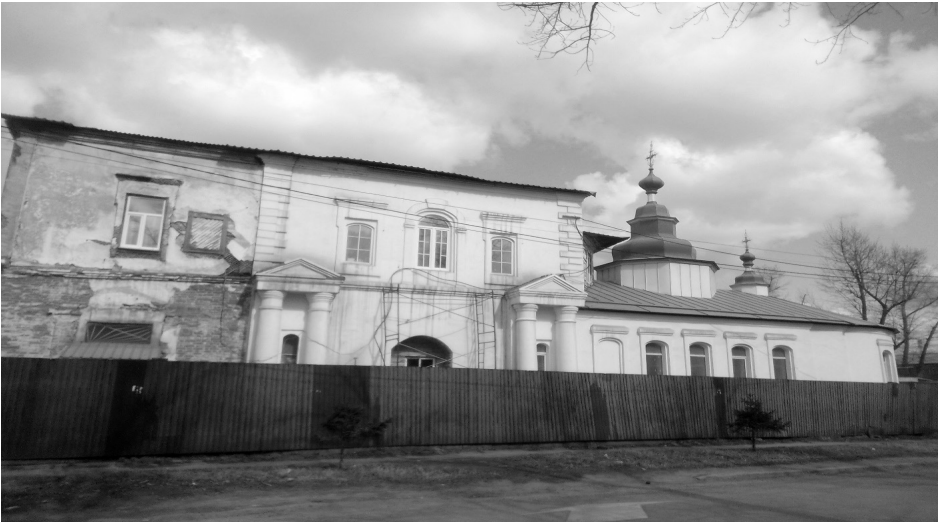
Фото 1 – Общий вид с ул. Шевцова
