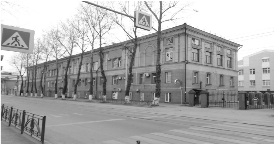
Фото 1 – Фрагмент главного юго-восточного фасада
