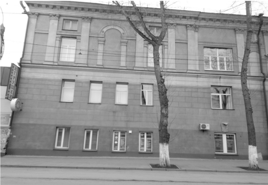
Фото 2 – Фрагмент главного юго-восточного фасада
