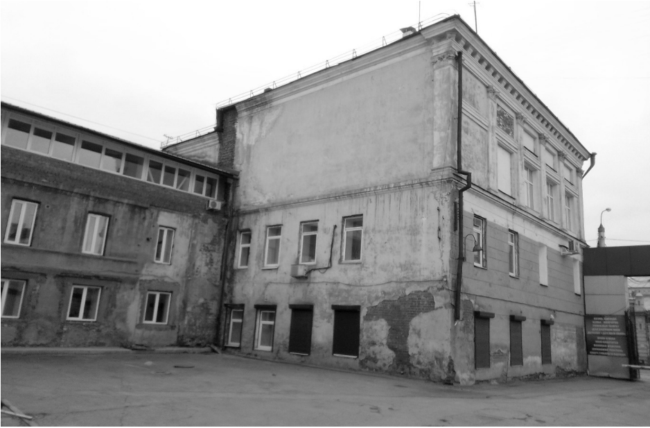
Фото 4 – Фрагмент северо-восточного фасада
