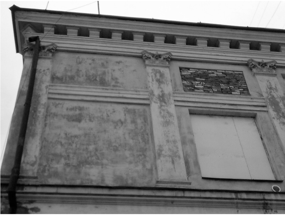
Фото 5 – Фрагмент северо-восточного фасада
