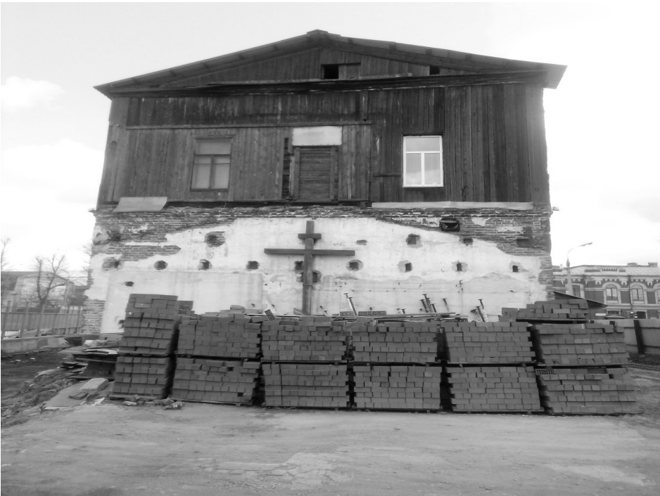
Фото 3 – Торцевой (западный) фасад
