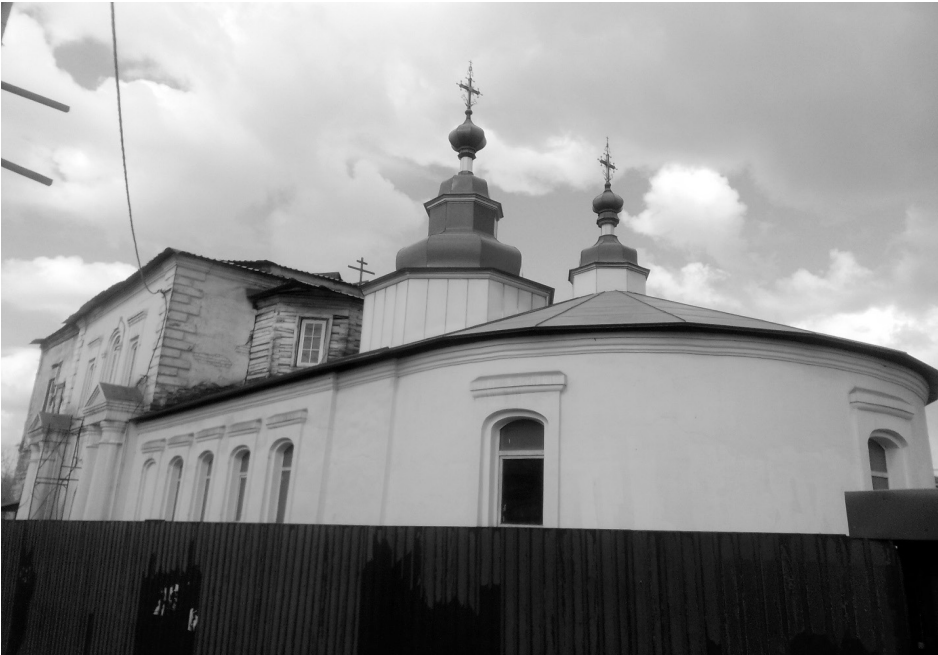
Фото 2 – Фрагмент главного фасада
