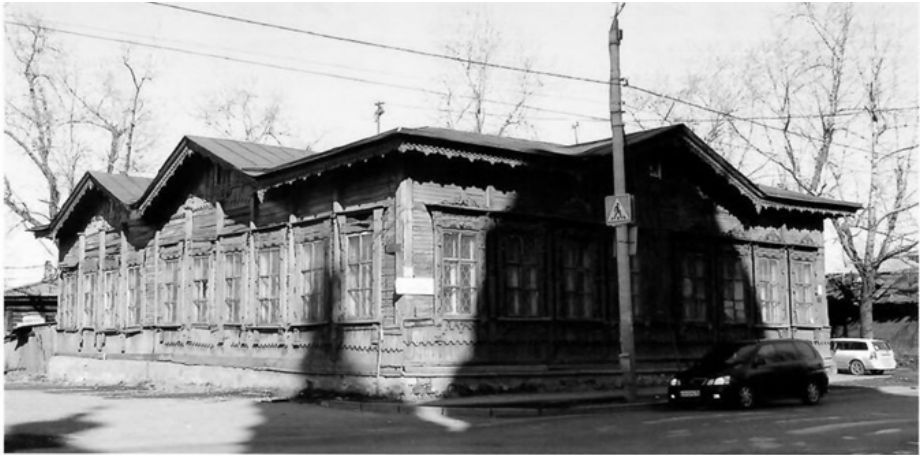
Общий вид здания со стороны ул. Баррикад
