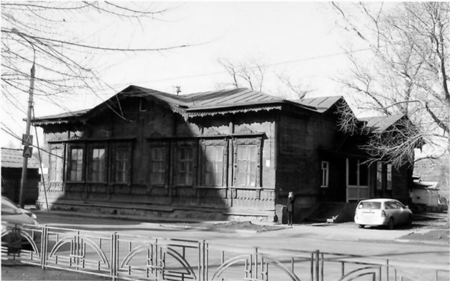
Общий вид здания со стороны ул. Баррикад
